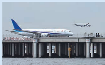
【羽田空港第4滑走路支える鋼管杭】
