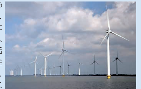
【洋上風力発電タワーの例】
